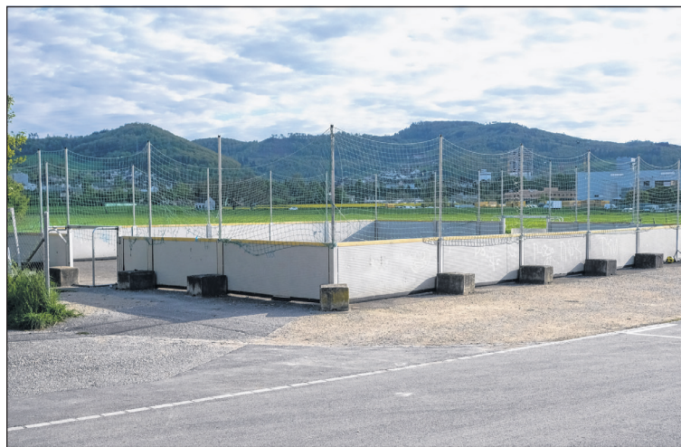
Auf der Parzelle des Kantons Ecke Netzbodenstrasse/Wyhlenstrasse wird das Erstaufnahmeheim entstehen.
